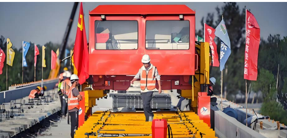
▲ 无砟轨道成套智能施工设备首次在济滨高铁正式投入使用
