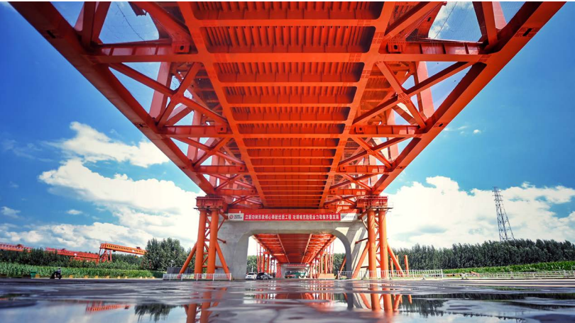
济滨高铁济阳黄河公铁两用特大桥主桥钢梁实现首次合龙
